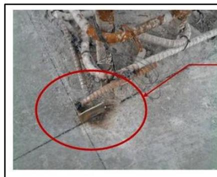
**Gambar 3. 1** (Pekerjaan Pemarkingan Kolom)
