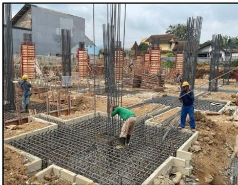
**Gambar 3. 3** (Memasang sengkang pada kolom)
