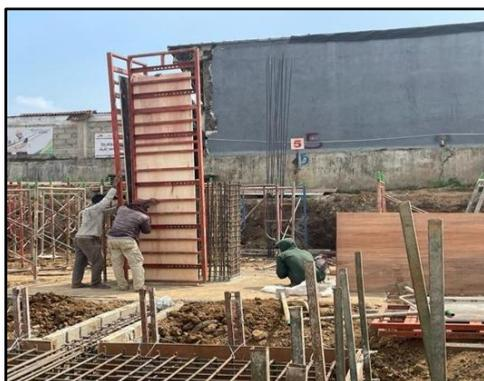
**Gambar 3. 5 ( Pemasang Bekisting Kolom )**
