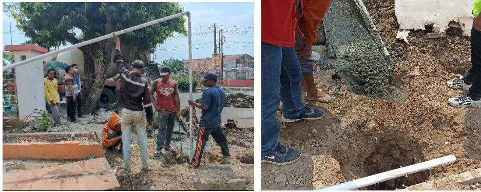
Gambar 7. Proses Pengecoran (Sumber : Dokumen Pribadi)
