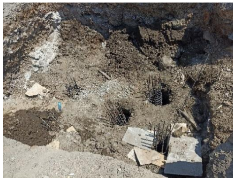
Gambar 6. Proses Pemasangan Besi Tulangan (Sumber : Dokumen Pribadi)
