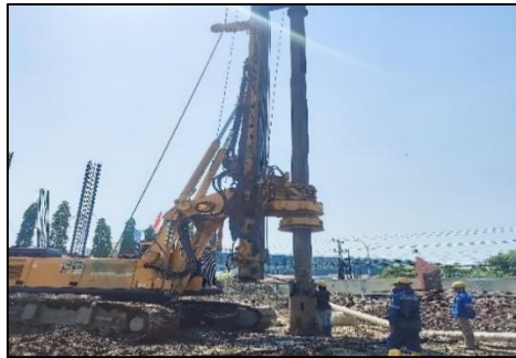
Gambar 5. Setting Alat Pengeboran
