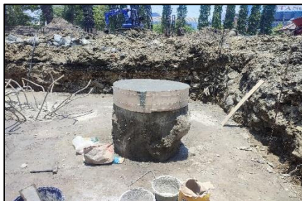
Gambar 16. Kondisi Bored Pile Setelah Pengecoran
