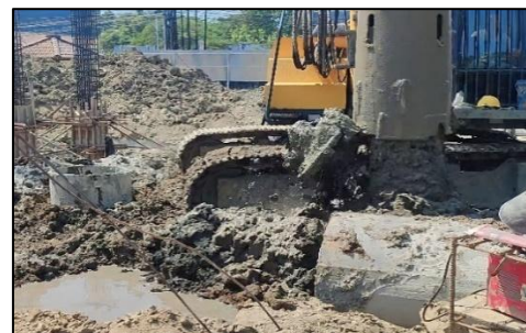
Gambar 10. Pembersihan Lubang Bor
