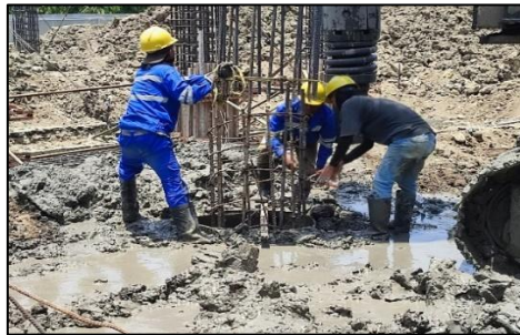
Gambar 12. Pemasangan Tulangan Segmen 2
