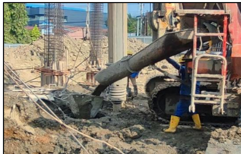
Gambar 15. Proses Pengecoran
