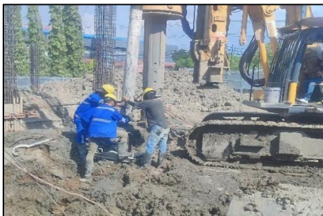
Gambar 13. Pemasangan Pipa Tremie
