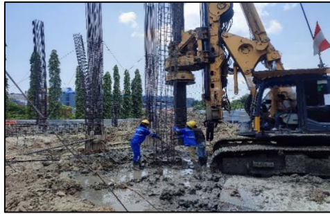
Gambar 11. Pemasangan Tulangan Segmen 1
