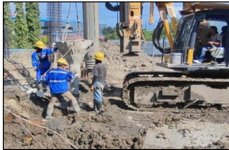
Gambar 14. Pemasangan Concrete Bucket
