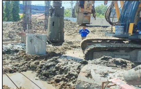
Gambar 8. Pemasangan Temporary Casing
