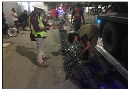
Gambar 2 Pemasangan Besi Tulangan
