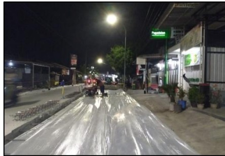
Gambar 1 Pemasangan plastik cor
